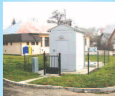
Čerpacia stanica 2 Moštenec
