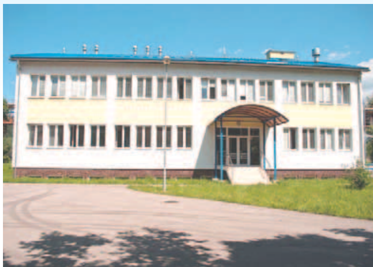
Obr.: Prevádzková budova ČOV v Považskej Bystrici
